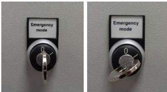
2. Schlüsselschalter auf Position 1 stellen. Pumpe läuft an
