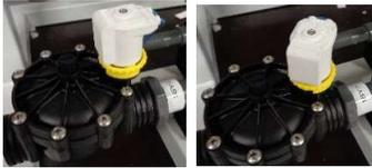
2. Eingangsventil manuell öffnen. Hierzu weiße Magnetspule um 45° gegen den Uhrzeigersinn drehen.
